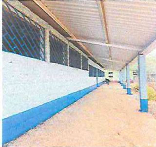
Foto 1: Culminación de entechado, para 3 aulas y corredor en el modulo .
