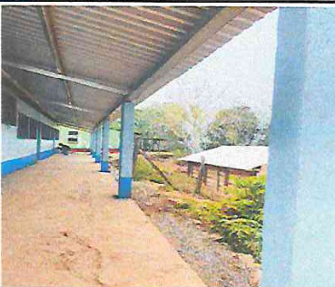
Foto 3: Mejoramiento de columnas de concreto del corredor de 3 aulas en el modulo 1.
