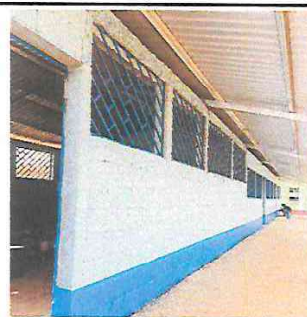
Foto 4: ampliación de ventanas para una buena ventilación dentro de cada aula en el modulo .
